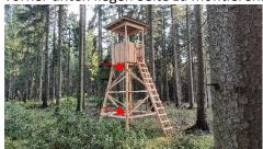
5. Als nächstes sollen die 2 bzw. 4 Diagonalstreben montiert werden. Dazu wird die erste Strebe oberhalb der Waagerechtstrebe mit dem spitzen Winkel bündig mit 2 Stck 6x100mm befestigt (roter Pfeil), auf der anderen Seite der Strebe nur eine Schraube anstetzen, nicht verschrauben!!. Nun mit einem Maßband per Kreuzmessung (blaue Pfeile) von der Unterseite eines Ständers zur gegenüberliegenden Ecke am Fussboden der korrekt eWinkel hergestellt werden und die
