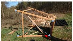
Nun werden die Eckdiagonalen mit je 4 Stck 6x80mm verschraubt. Dabei immer zuerst eine Schraube von aussen verschrauben und dann von innen
