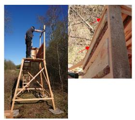
10. Wenn beide Seitenwände montiert sind und vor der Vorderwandmontage, muss das Dach mit einem Seil an der Vorderwandseite hochgezogen werden und auf die Seitenwände gelegt werden. Dazu wird dieses mit senkrecht stehendem Dachplattenprofil mit der Unterseite gegen das Gerüst gelehnt. Dann wird an der oberen Querlatte des Daches mittig ein Gurt angebracht. Achten Sie auf sichere Verknotung!
