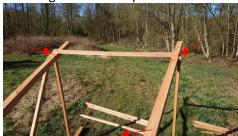
Nun wird das Gerüst vorsichtig um 90° gedreht, um dann die gleichen Streben an der vorher unten liegen Seite zu montieren.
