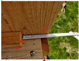
Auch diese wird dann mit 4 Stck 6x120mm auf dem Boden befestigt und zusätzlich mit 4 Stck 5x60m von aussen mit der Türrahmenwand verbunden.
