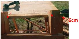
9. Nun können die Seitenwände angebracht werden. Dazu achten sie bitte unbedingt auf eine Absturzsicherung, wie in den Sicherheitshinweisen beschrieben. Dazu wird als erstes die Wand mit dem Türrahmen mit einem Seil nach oben gezogen oder von unten hochgereicht und mit 3 stck 5x70 auf dem Boden verschraubt. Dazu müssen rechts neben der Bodenleiste wie bei der Leiter wieder 6cm bis zur Ecke frei bleiben um hier dann die erste Seitenwand platzieren zu können.
